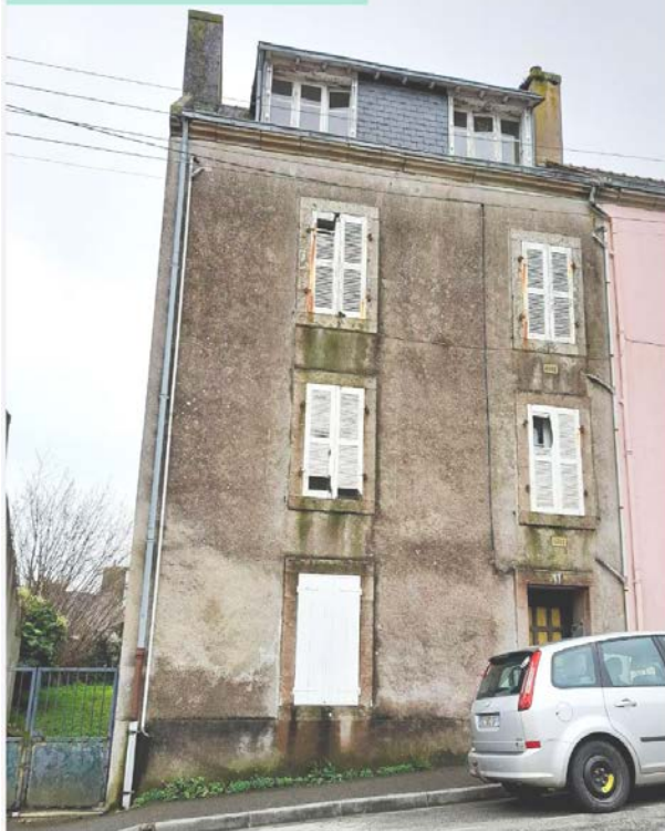
Fiche immeuble 1 | 11 rue Laënnec
