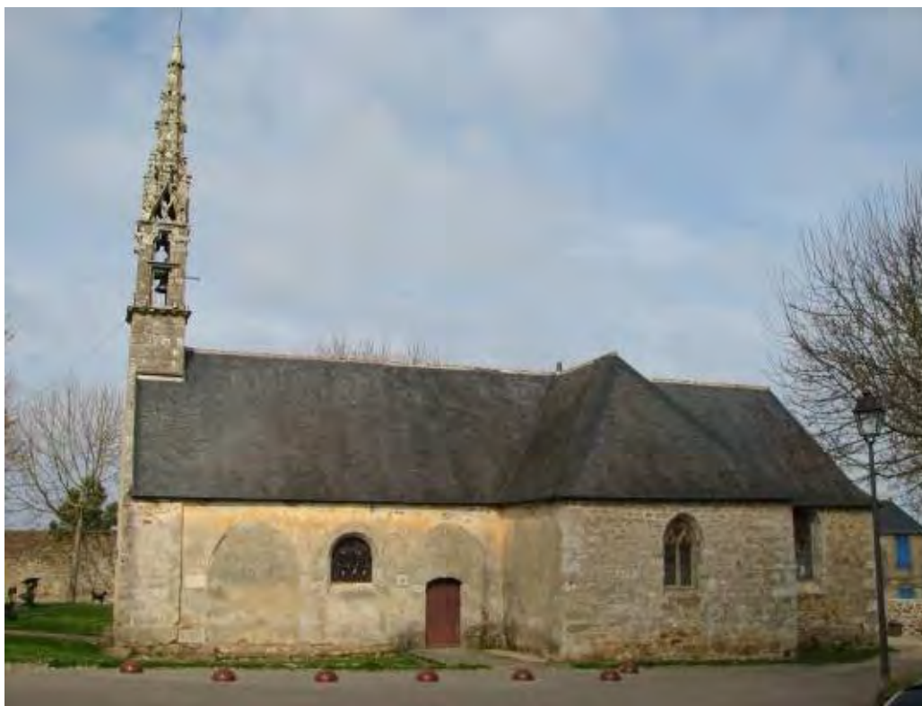
Chapelle Saint- Jean de Tréboul : clocher – Monument historique classé le 25/11/1924
