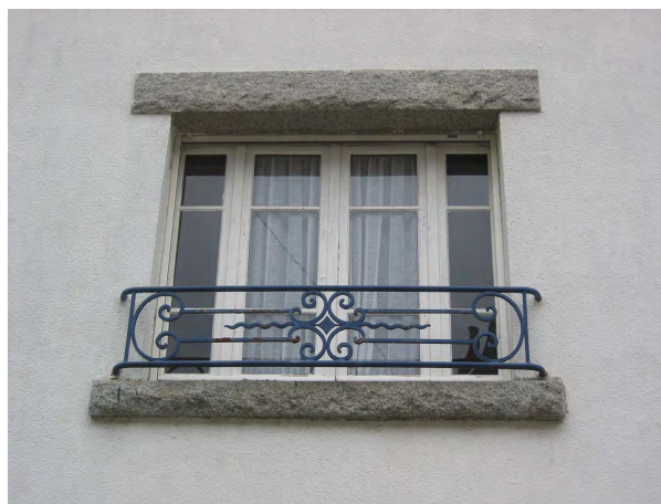
Volet roulant intégré dès l'origine de la construction.
