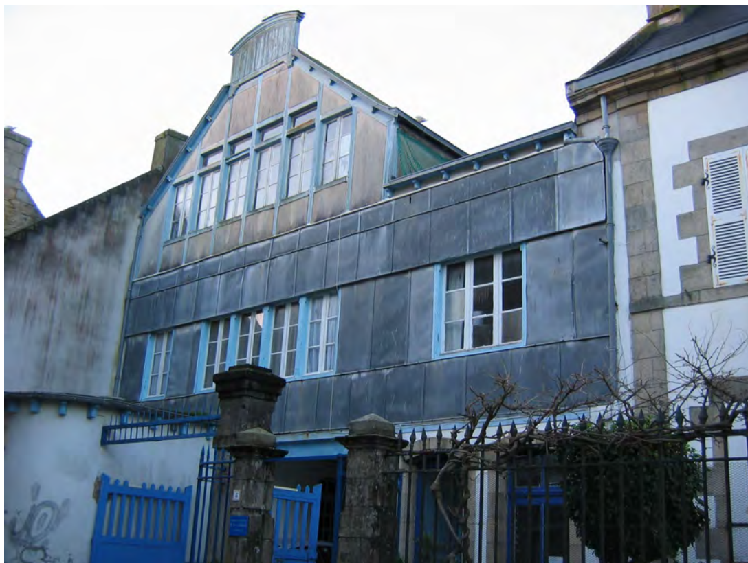
Immeuble rue du Couëdic
