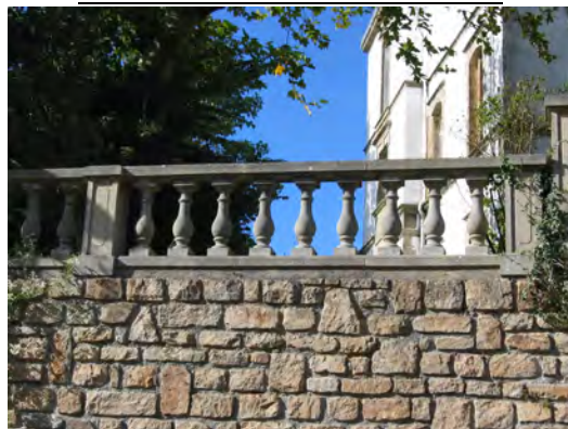
Exemple de mur de soutènement, couronné de balustres de béton.
