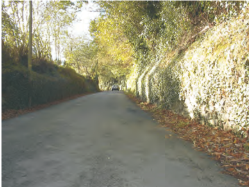
Talus avec soubassement de petits blocs minutieusement appareillés.
