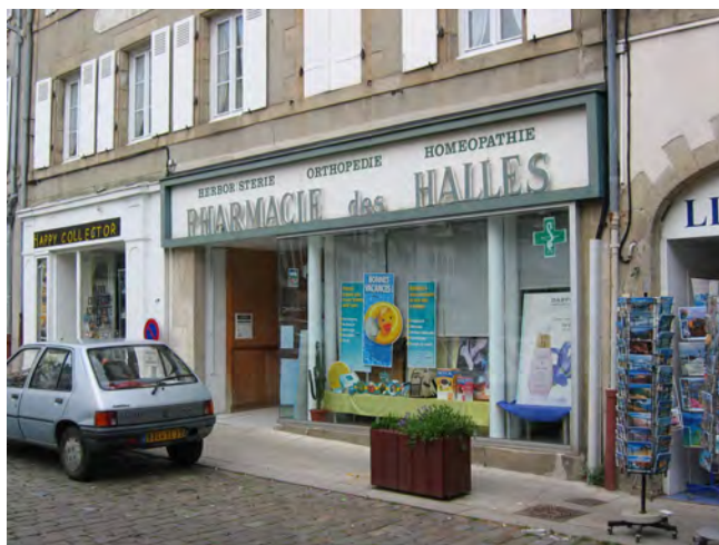
Exemple de vitrine ne respectant pas la typologie de l'immeuble – façade éventrée
