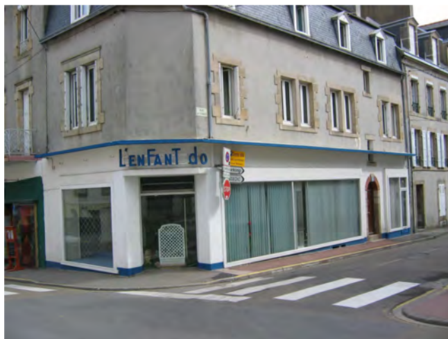
Exemple de vitrine non intégrée à la façade
