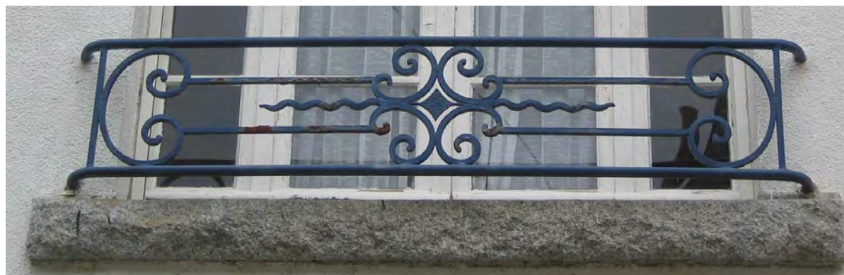
Garde-corps métalliques en encorbellement
