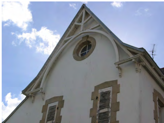
Exemple : Rue du Pont
